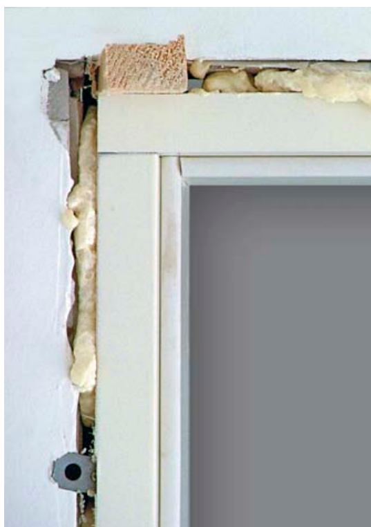
Esempio di errato raccordo della cassaporta alla muratura, che può comportare una perdita di potere fonoisolante di anche 8 dB.
