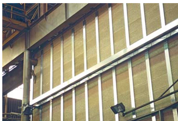
Parete fonoassorbente monostrato con struttura a vista in acciaio inox; particolare attacco della trave orizzontale.
